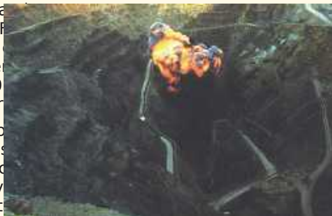
Pega (Voladura) en la “Corta Aznalcollar” en 1996
